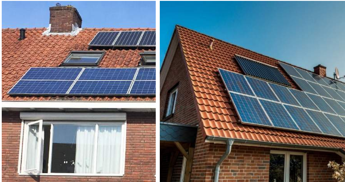
Figuur 14: Zonnepanelen op een woning. Hoe grote het percentage van een dak dat bedekt wordt, hoe koeler de temperatuur onder een dak.
