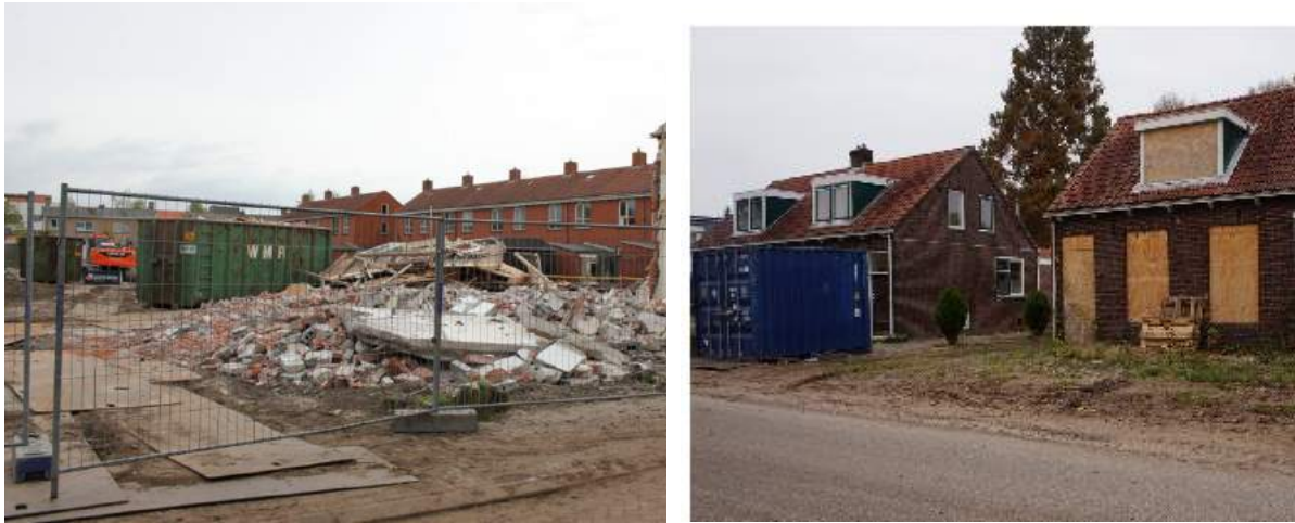
Figuur 15: Gesloopte woningen (met vleermuizen) in Dokkum en Heerenveen.
