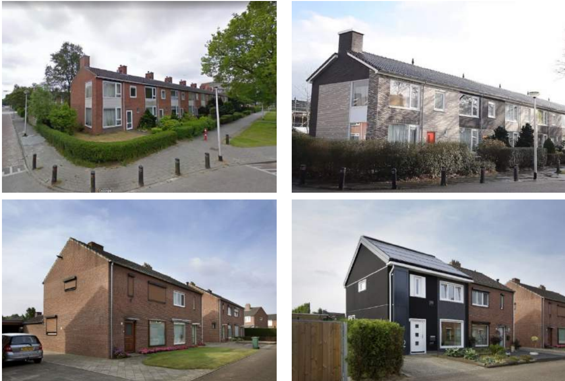
Figuur 7: twee voorbeelden van woningen waarbij zowel de gevel als het dak is vervangen, links de situatie voor de verbouwing, rechts de situatie erna. Door een toepassing van een dikkere isolatie laag is de dakrand constructie veranderd.
