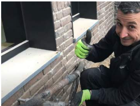
Figuur 9: De spouwmuur opvullen met vloeibaar isolatiemateriaal (pur, eps, parels, etc)
