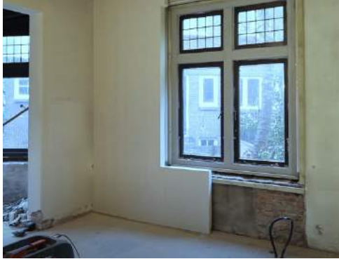
Figuur 11: Twee voorbeelden van isolatie werkzaamheden van binnenuit.
