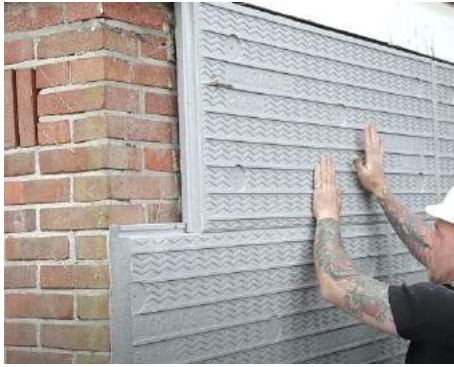
Figuur 12: Twee voorbeelden van isolatie van buitenaf. (Boven) het plaatsen van een kant en klare langevel. (Onder) het plaatsen van isolatie materiaal op een bestaande gevel. Hierbij worden eventuele openingen (zoals een lintvoeg / stootvoeg) afgedekt.
