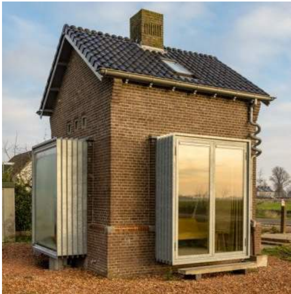
Figuur 37: Herbestemd trafo huisje in Wirdum, nu een B & B.
