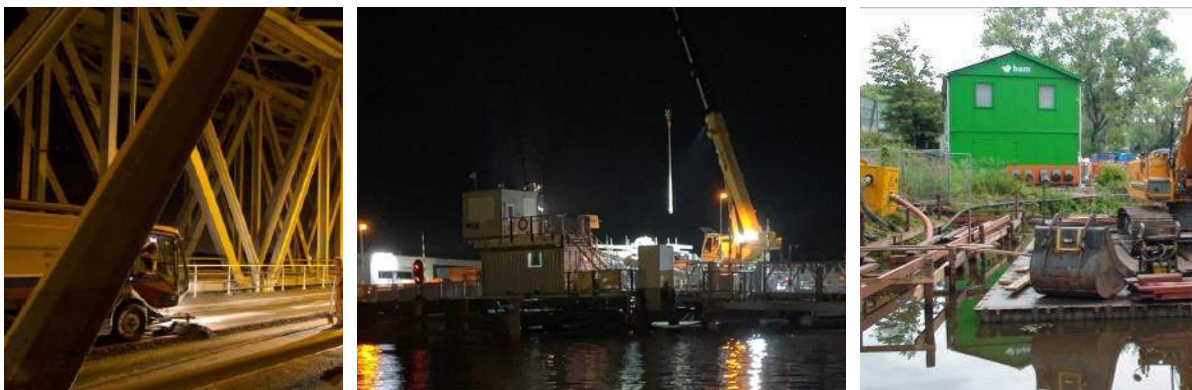
Figuur 20: Voorbeelden van tijdelijk afsluiten van een vaart door pantons met materieel en het verlichten van een brug tijdens werkzaamheden.
