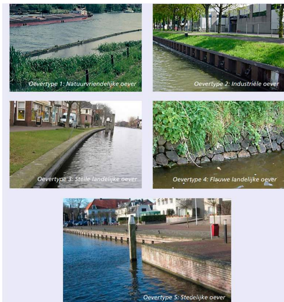
Figuur 27: 5 veel gebruikte oevertypes, 1 natuurvriendelijke oever (NVO), 2- industriële oever (IO), 3- Steile landelijke oever (SLO), 4- flauwe landelijke oever (FLO) en 5-Stedelijke oever (SO) . Afkomstige uit: Dienst beheer infrastructuur (2017). Handboek Ontwerpcriteria Vaarwegen. Provincie Zuid-Holland.
