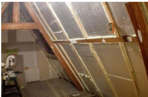
Figuur 4: Twee voorbeelden van isolatiewerkzaamheden van binnenuit.
