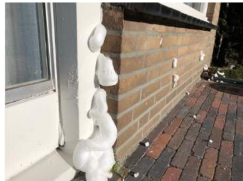
Figuur 8: Voorbeeld van een boorschema. Alle mogelijke randen waar materiaal uit zou kunnen komen worden meestal van te voren gedicht.
