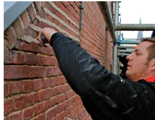
Figuur 13: het uithakken van voegen gebeurt o.a. met een hakhamer, luchthamer of met een slijptol met een speciaal voeg snijblad.
