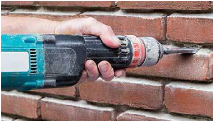
Figuur 13: het uithakken van voegen gebeurt o.a. met een hakhamer, luchthamer of met een slijptol met een speciaal voeg snijblad.
