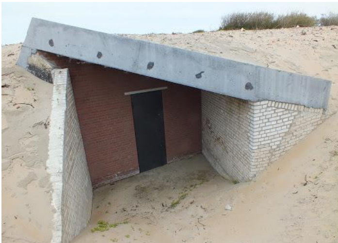
Figuur 60. Voorbeeld van een (niet al te goed werkende) zandkering bij de vleermuisbunker aan de Wassenaarse slag.
