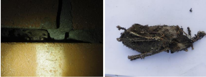
Figuur 47. Links: Waternes in open voeg in bunker nr. 5. Rechts: dode Waternes uit bunker nr. 6.
