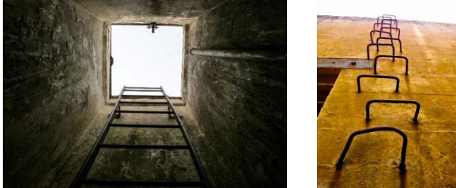
Figuur 61. Voorbeeld van steile ladders in een bunker, met sporten of losse ijzers in de muur.
