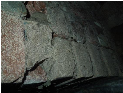
Figuur 19. Dubbele halfsteens op elkaar gemetselde segmentboog
