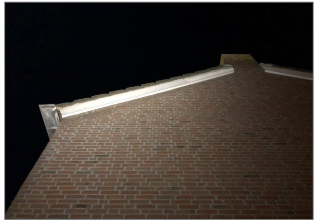
Afbeelding 3.3 | Tussen de dakrand en de buitenmuur kunnen de meervleermuizen langs de gehele gevel uitvliegen.
