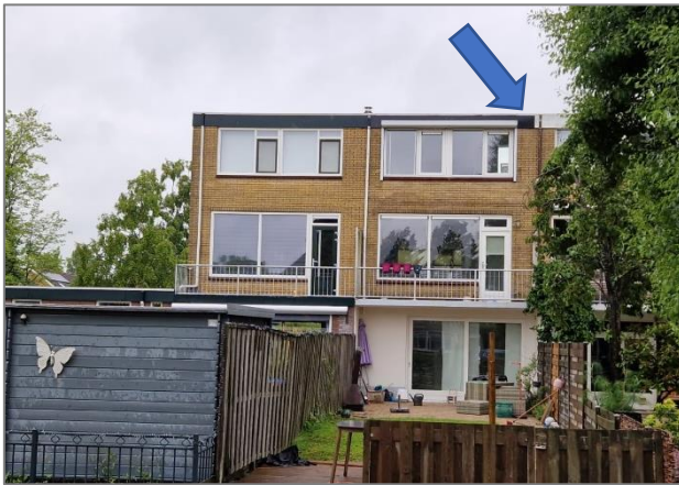
Afbeelding 3.5 | Achterzijde van de Gabrielstraat 43-45 waar de kolonie onder de daklijst op de erfrens uitvliegt.
