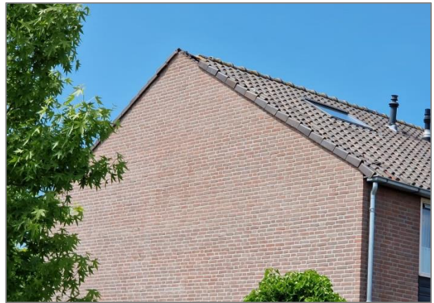
Afbeelding 3.11 | De kopgevel waar de kolonie is gevonden. In de nok ontbreken drie kantpannen. De meervleermuizen vliegen langs de gehele zijgevel uit.
