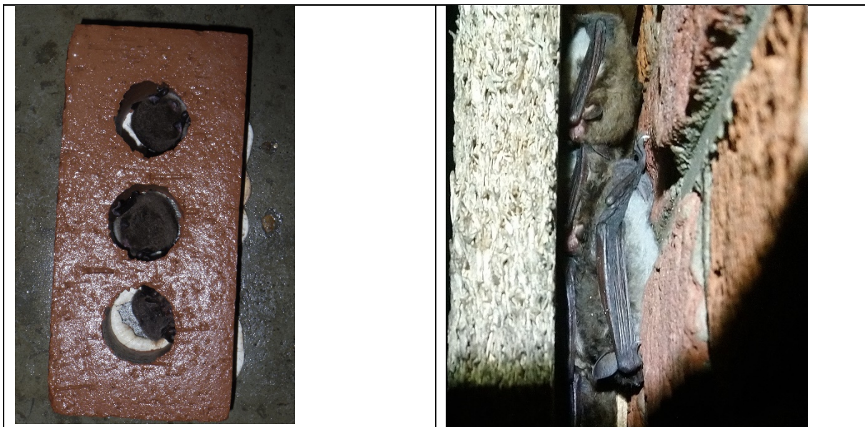
Figuur 51: veilige hangplekken voor vleermuizen, een holle steen en een houtwolcementplaat.
