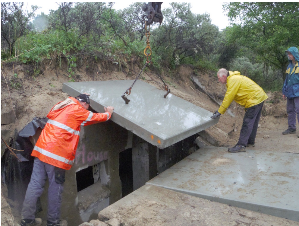
Figuur 12: Hier wordt de gang voor een bunker bedekt met stelcon platen, waarbij de nieuwe ingang (voor mens en vleermuis) om de hoek komt te liggen. Met een dergelijke ingreep verandert het klimaat in een bunker sterk (zie tabel 6), daarom is hiervoor altijd overleg met een vleermuisdeskundige nodig. Vanwege kans op verstoring kunnen dergelijke werkzaamheden alleen worden uitgevoerd in de voor vleermuizen minst kwetsbare periode (tabel 7).
