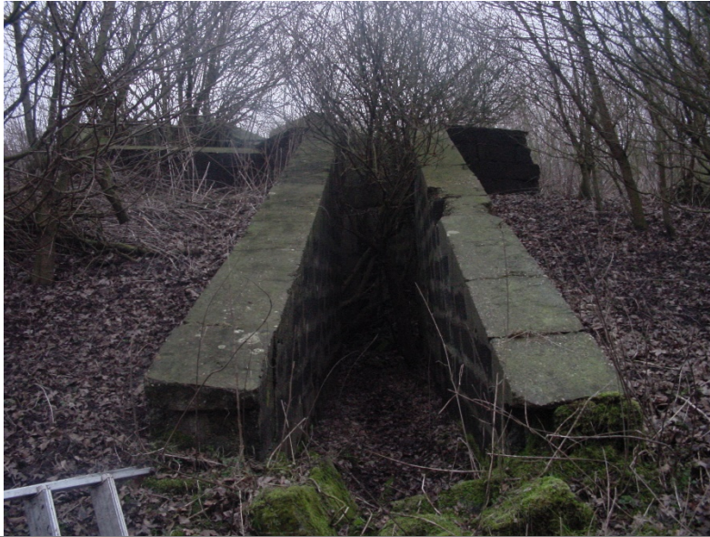
Figuur 42: Gangen verbinden de bunkers (fotograaf: Fons Bongers)
