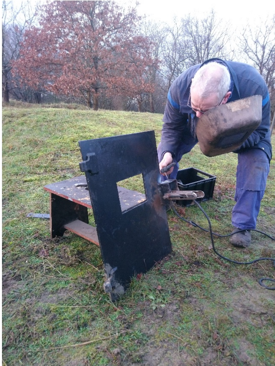
Figuur 13: Een noodreparatie in de winter. Om te voorkomen dat vleermuizen wakker worden van de lasdampen is de deur uit de scharnieren getild. En wordt buiten de bunker gerepareerd.
