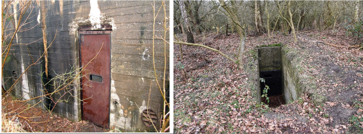
Figuur 22: Bovengrondse bunker met vleermuisdeur (fotograaf Gerd Mascher). Rechts: ondergrondse gang met bunkers (Christian Dietz).
