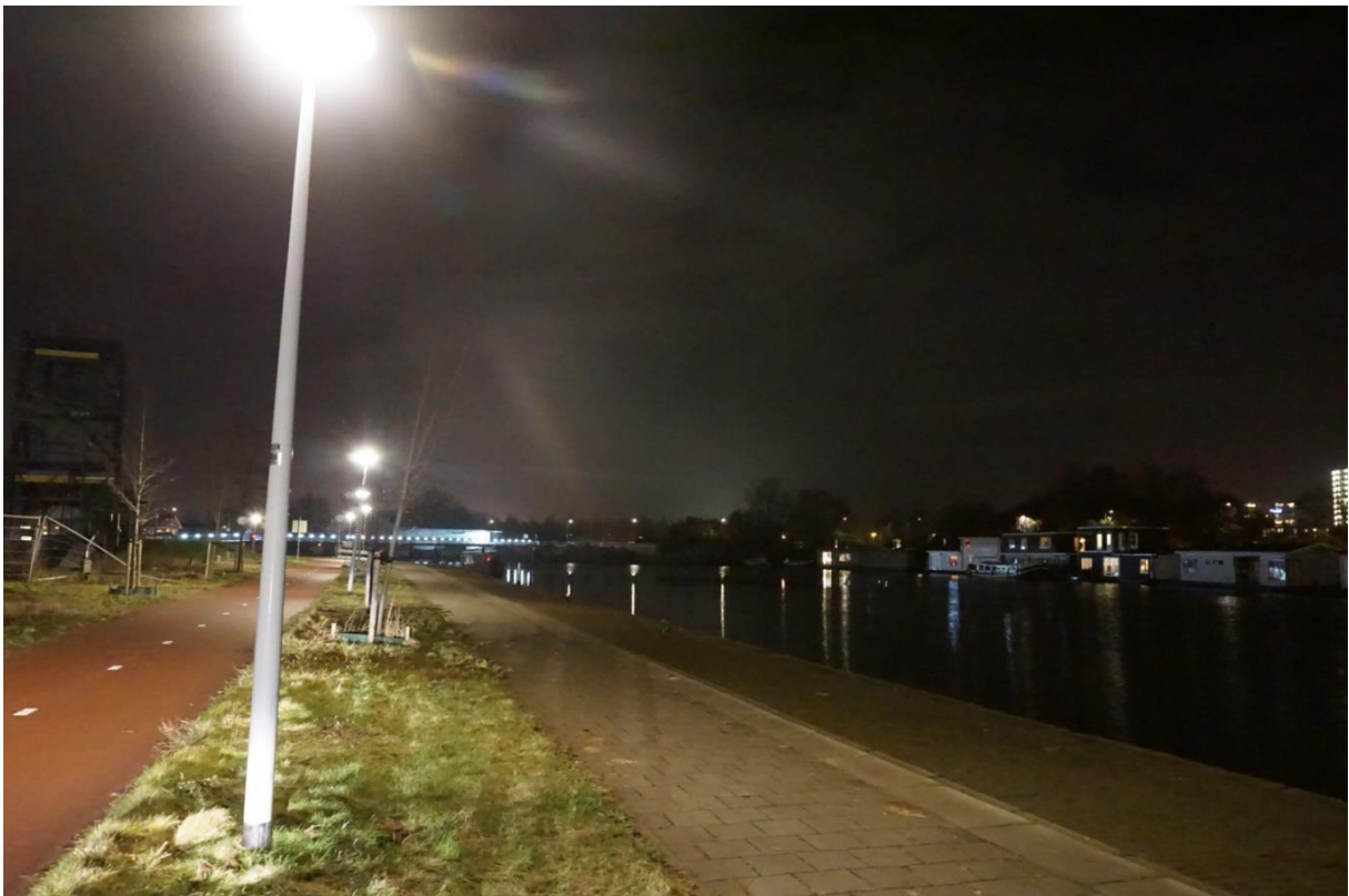
Figuur 21. Fietspaden langs het water zijn vrijwel altijd verlicht met rondstralers, deze verlichten niet alleen het fietspad maar ook het nabijgelegen wandelpad en het water.
