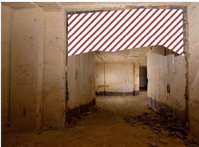
Figuur 68: De randen van een champignonwand kunnen tot en met het gearceerde gebied worden weggehaald. Hiermee wordt de hoeveelheid mogelijke luchtstroming vergroot.
