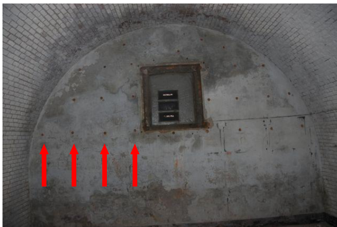
Figuur 72: Aanpassing aan een ingang (invliegopening voor vlermuizen minimaal 14 bij 20 cm), gaten in de binnenmuur. Note: baksteen heeft heel andere thermische eigenschappen als beton. Vanwege het betere vermogen om vocht langzaam af te staan, heeft het de voorkeur om bij het afsluiten van mergelgroeven baksteen te gebruiken.
