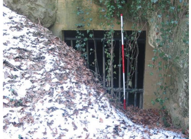
Figuur 65: (links) De afsluiting van de Schenk van binnenuit gezien. Aan de binnenzijde zijn weer stalen staven opgehangen. Bij onvoldoende luchtcirculatie loopt een ingang vaak vol met bladafval, zoals te zien bij de onderste twee buizen.
