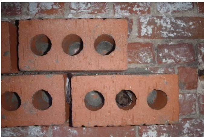
Figuur 59: Holle bakstenen van het merk Boerkens65, met 3 gaten (18x8,5x6,5), een Belgisch type baksteen, te koop bij de Brico in België. Deze bakstenen kunnen los worden opgehangen of ingemetseld in een frame. Op deze foto zijn 2 watervlermuizen te zien die gebruik maken van deze constructie.
